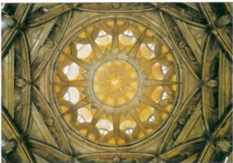
Guarino Guarini, interiorul cupolei capelei Sfântului Lintoliu din Domul din Torino, 1666-1681
